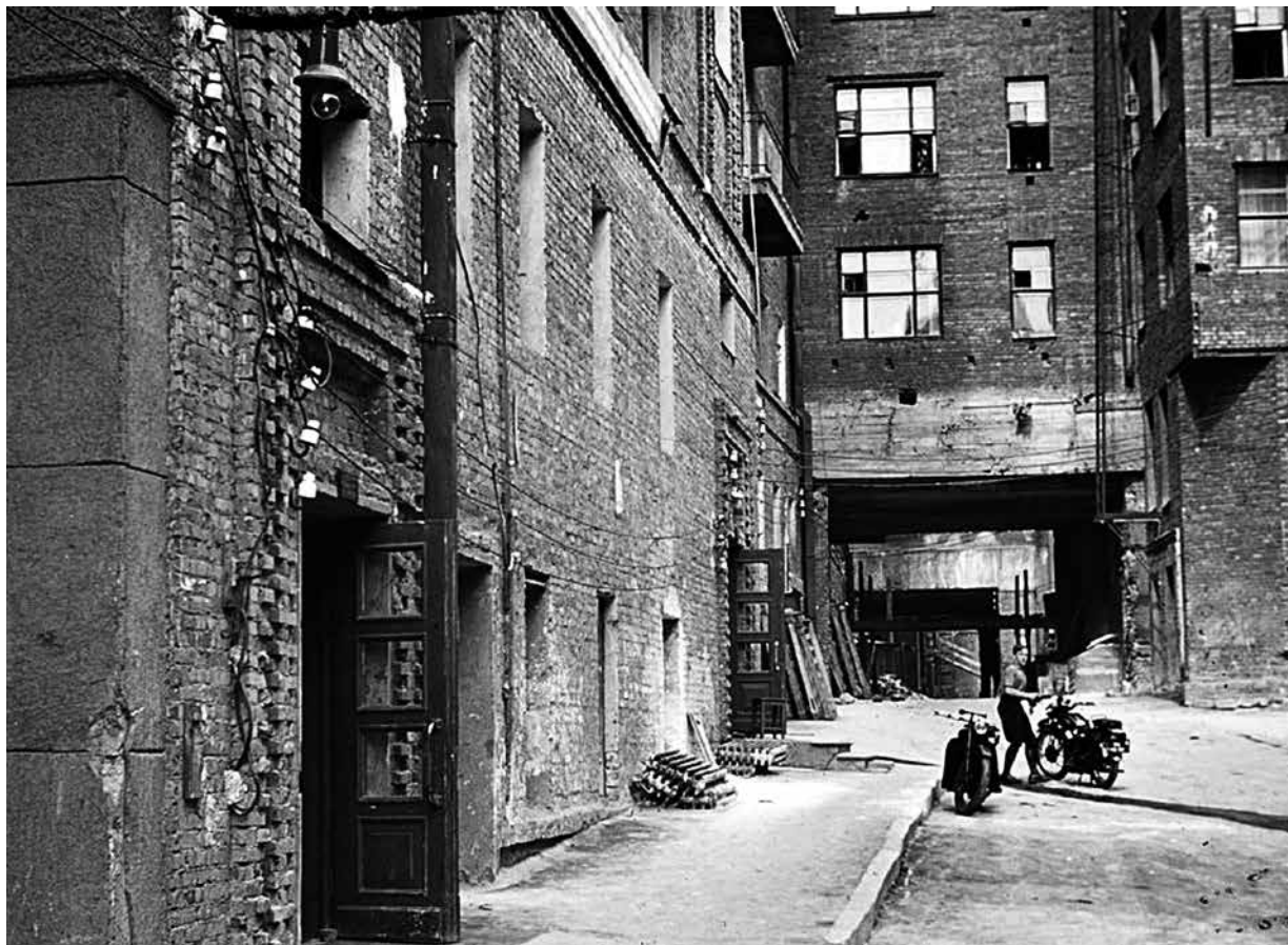
Двор на улице Горького. У входа в подъезд видна открытая электропроводка. Фото Х. Формана.
