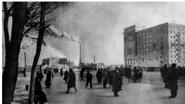
На шоссе Энтузиастов у Дангауэровской слободы за последние годы вырос прекрасный благоустроенный городок. На фото: заканчиваемый строительством дом для работников Сталинской ТЭЦ. Фото Л. Петрова.
