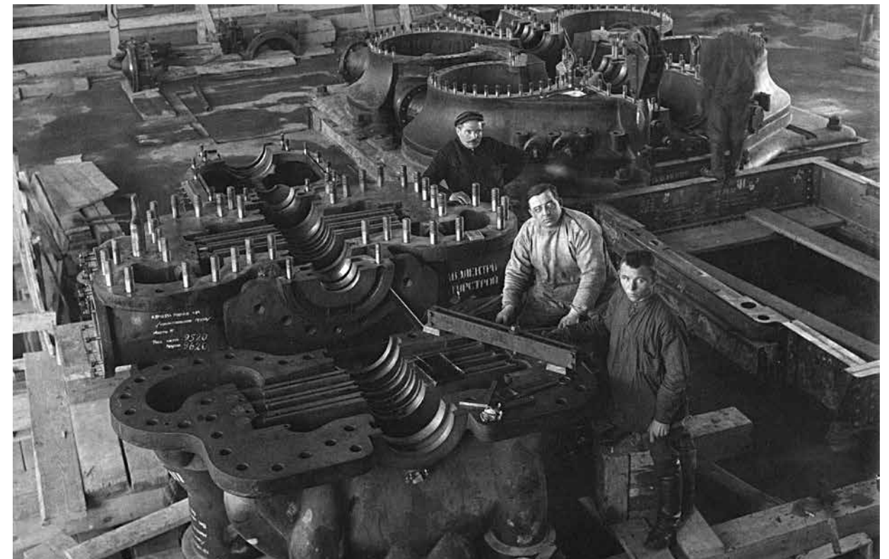
Выверка цилиндров высокого давления турбины 16 000 кВт.
