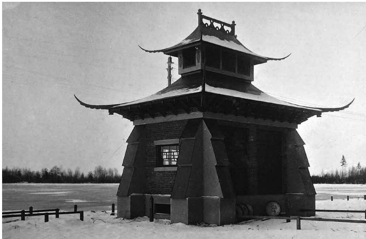
Трансформаторная будка в виде китайского домика.
