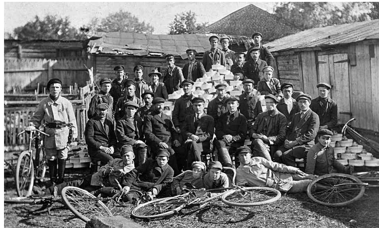
Работники Богородского кабельно-трансформаторного отдела. Начало 1920-х гг.
