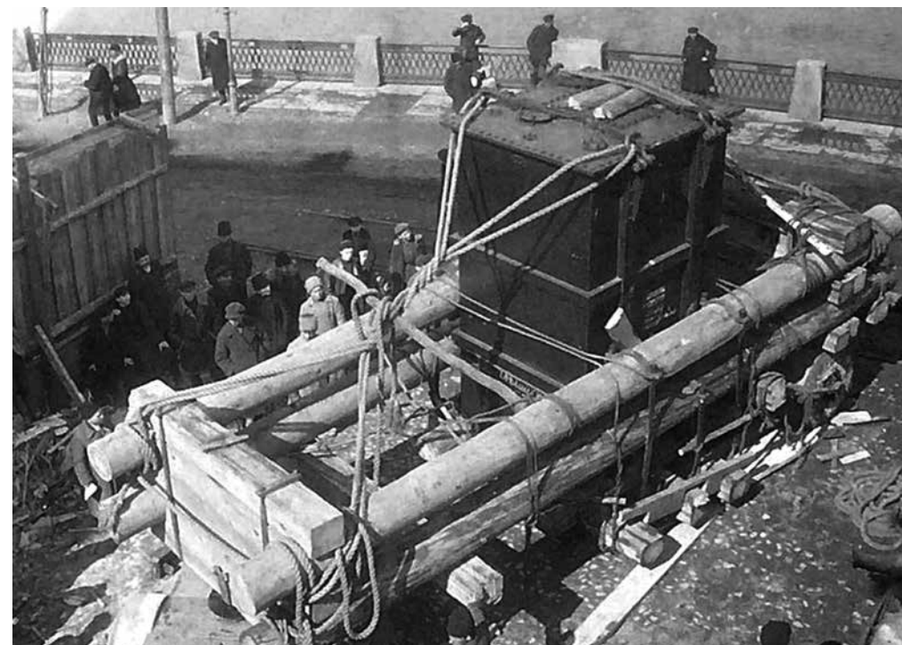
Разгрузка трансформатора на берегу Москвы-реки.
