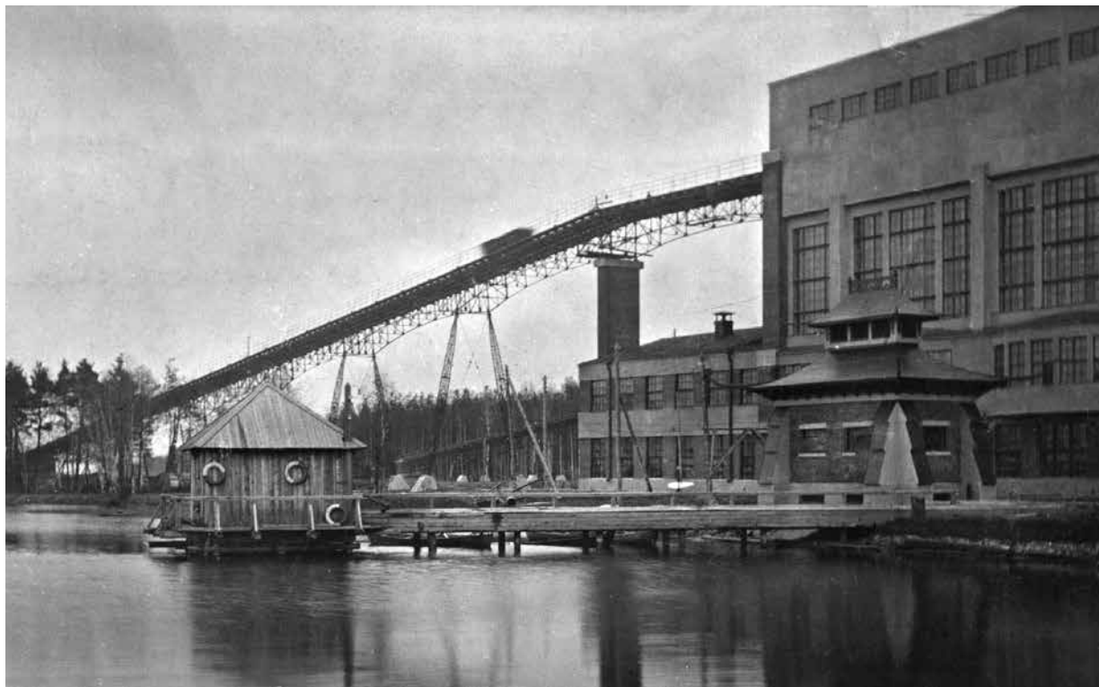
Вид на Шатурскую ГЭС со стороны Черного озера. На переднем плане насосная и трансформаторный киоск, на заднем плане – эстакада.
