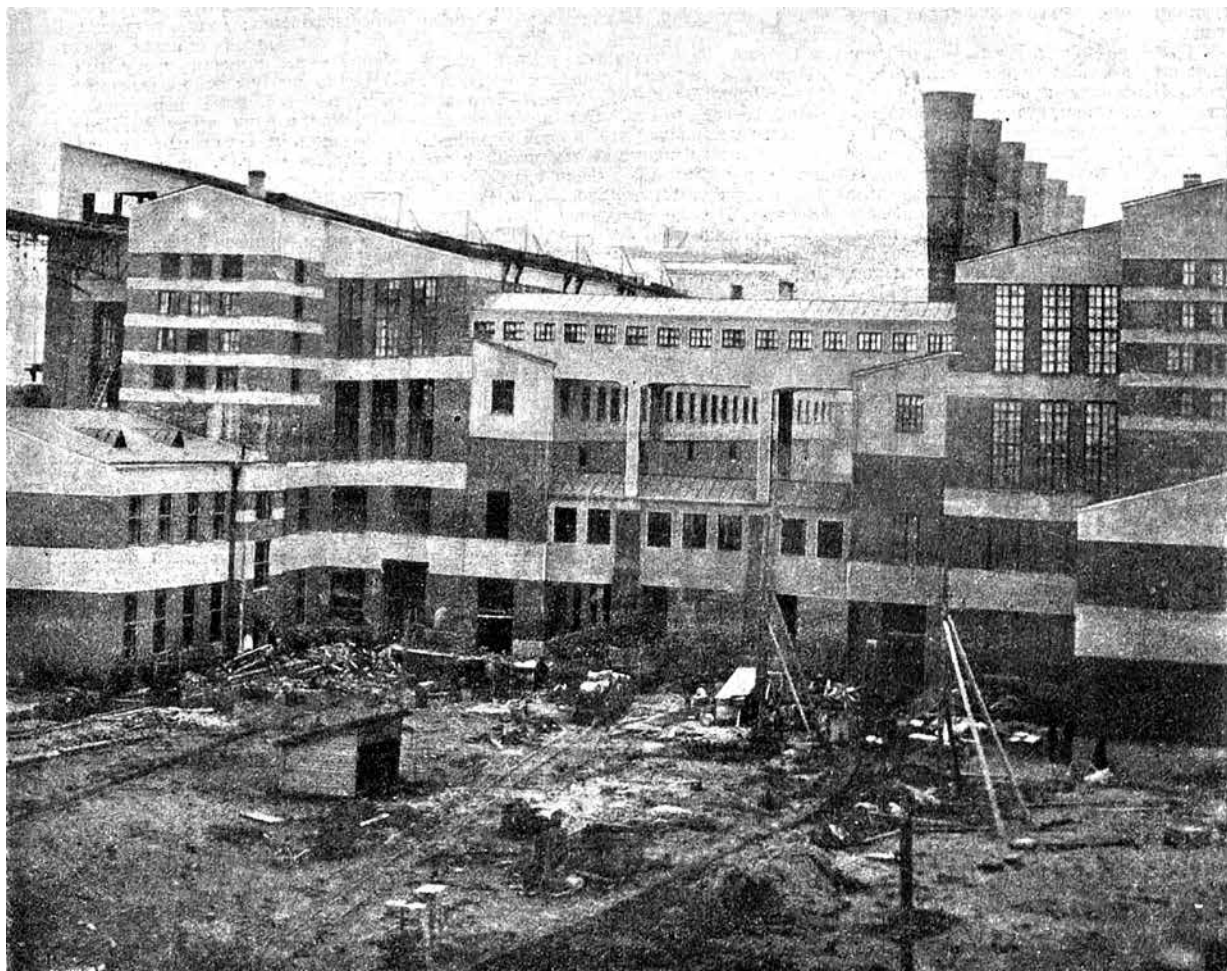
Общий вид Шатурской электростанции.
