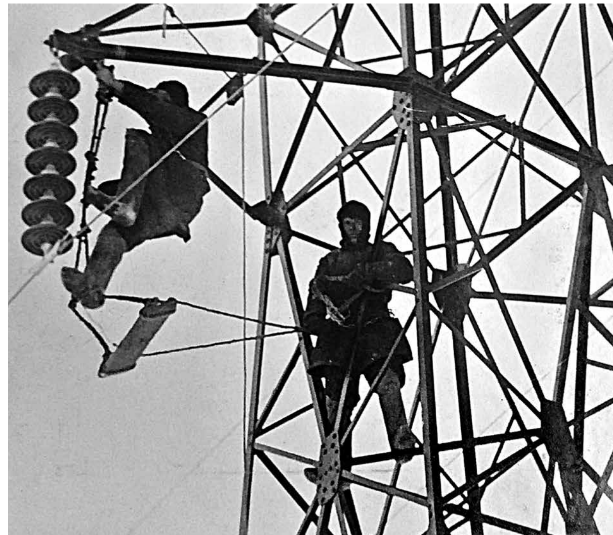
Подвеска изоляторов на высоковольтной линии Шатура – Москва.
