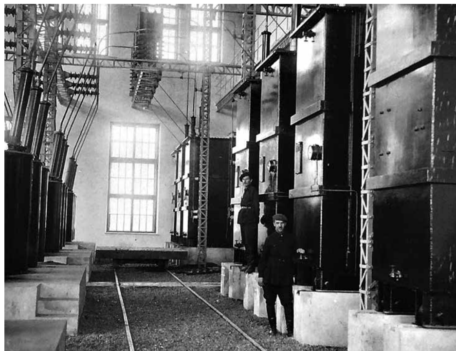
Закрытая подстанция. На снимке – К.Г. Шлегель и А.А. Глебов (сзади).
