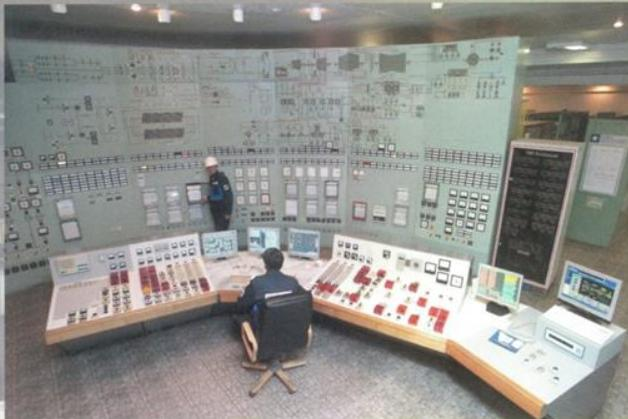
За годы работы значительно модернизировано оборудование цеха: реконструированы энергетические котлы (демонтированы циклонные предтопки, что значительно улучшило экологические показатели), на турбоагрегатах установлены питательные турбонасосы фирмы «Sulzer», внедрены системы автоматического контроля, сигнализации и регулирования ПТК «КВИНТ» и «ССС».
