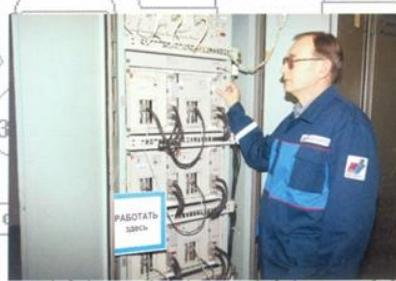
В связи с заменой турбины ст. №1 на Т-110-130 в 1997г. была выбрана система АСУ ТП на базе ПТК «Квинт-4», с помощью которой реализовались информационные функции и автоматическое регулирование технологического оборудования турбины, котла ТГМ-96 ст. №1, ОСО 1-й очереди ТЭЦ-23.
