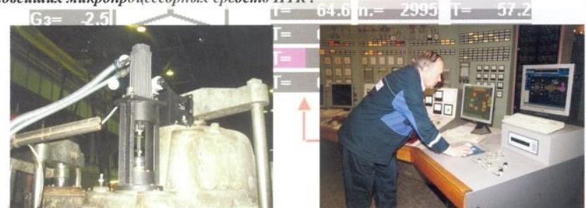
Использование ПТК при модернизации САРТ позволило осуществить интеграцию с САР котла на базе ПТК «Квинт» для создания системы автоматического управления мощностью энергоблока.
