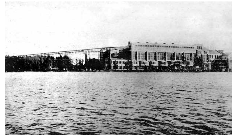
Рис. 1. Общий вид Шатурской ГЭС.
