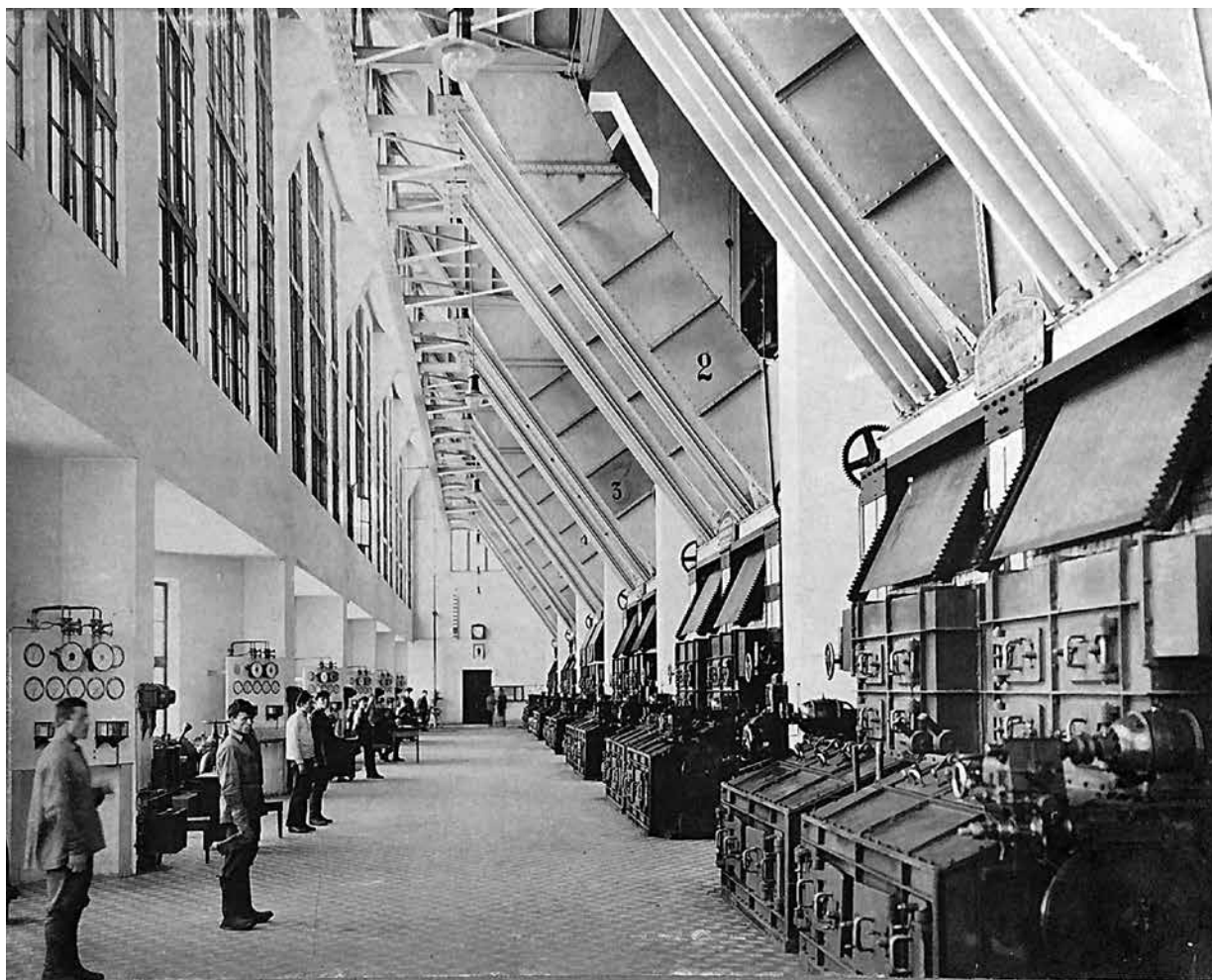
Рис. 2. Котельный зал ШГЭС.
