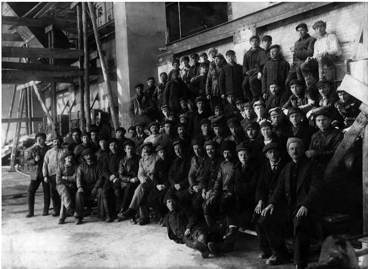
Работники Шатурской ГРЭС в котельной № 2.
