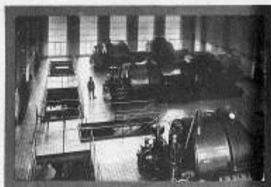
Внутренний вид ГЭС «Электросредча».
