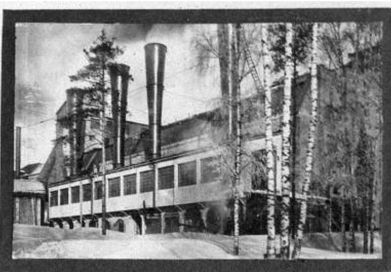
Новая котельная ГЭС „Электропередача“.
