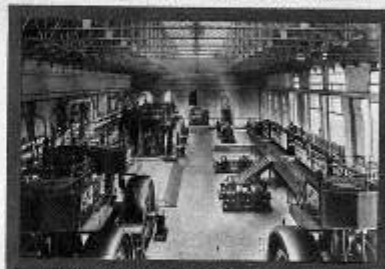
Внутренний вид Московской станции имени Сидоровича с первоначальной оснасткой.
