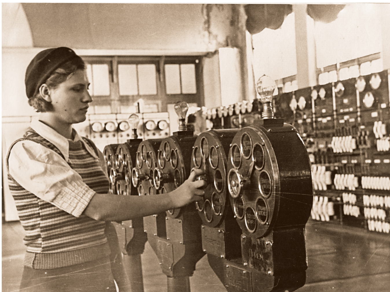
Пульт управления Шатурской ГРЭС. 1940 год
