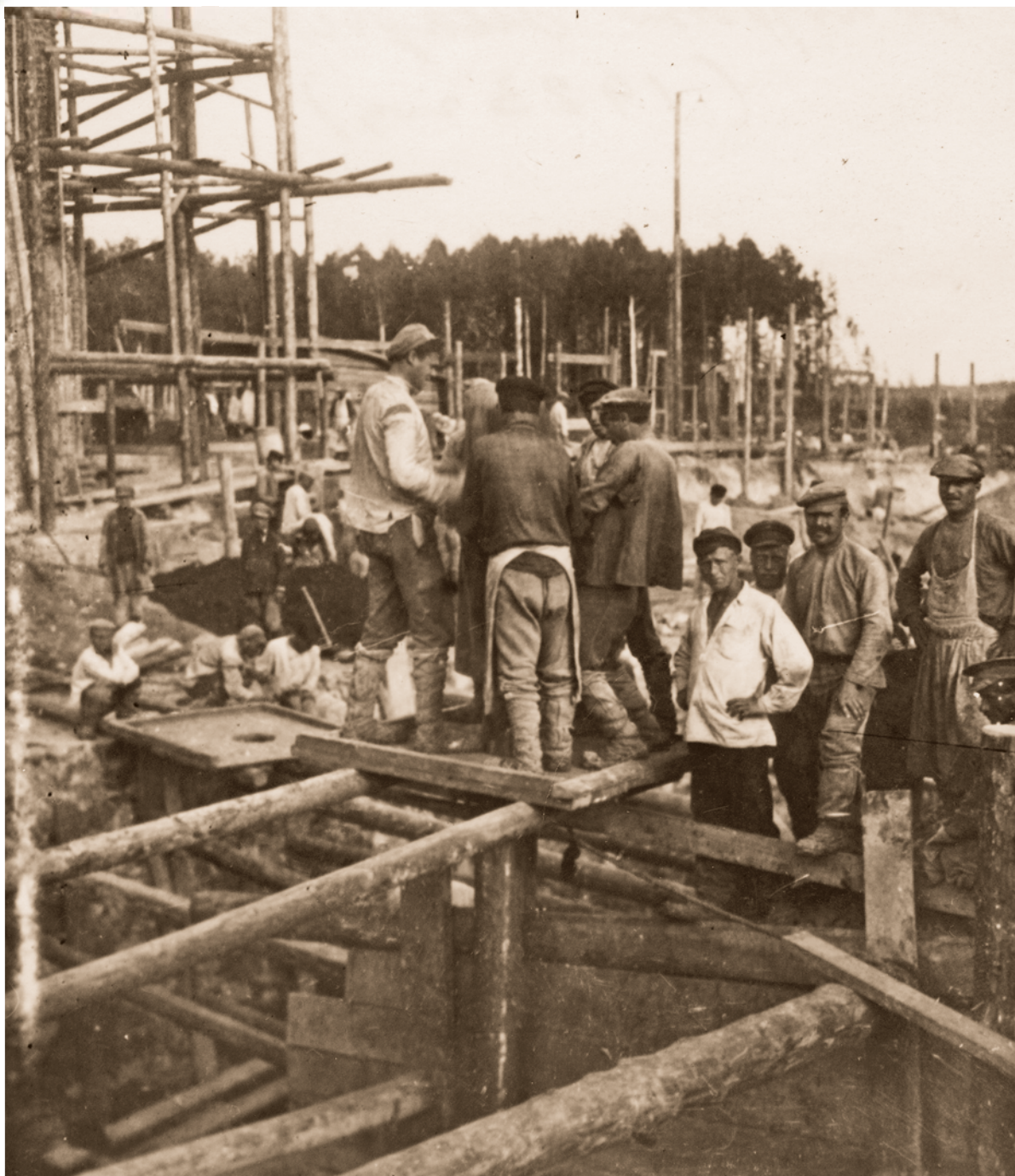
Строительство большой Шатурской электростанции. 1923 г.
