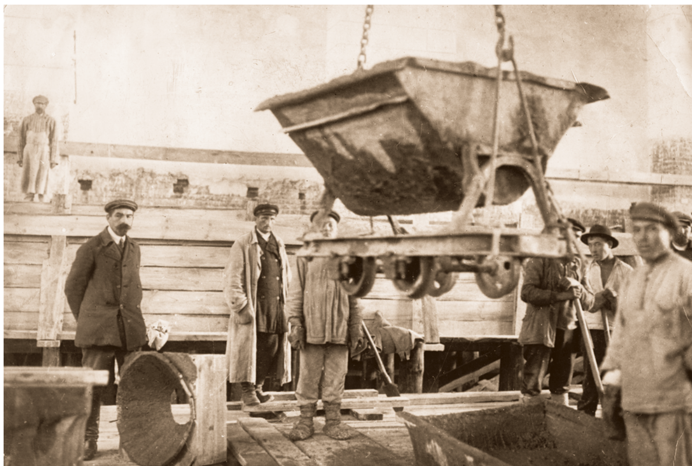
А.В. Винтер со строителями опытной Шатурской электростанции. 1920 г.
