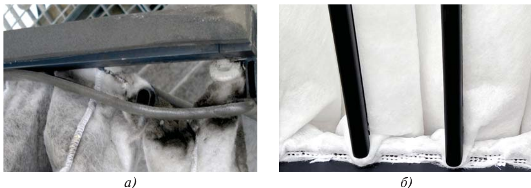
Рис. 3.59. Карманные фильтры компании E: а), б) фильтровальный материал не запаян в рамку фильтра
