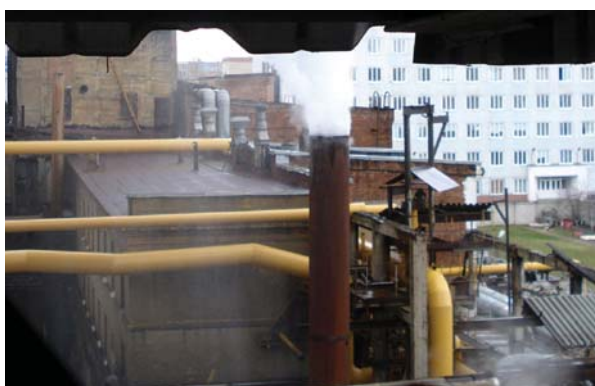
Рис. 2.44. Пар из барботера перед всасом КВОУ ГТУ
