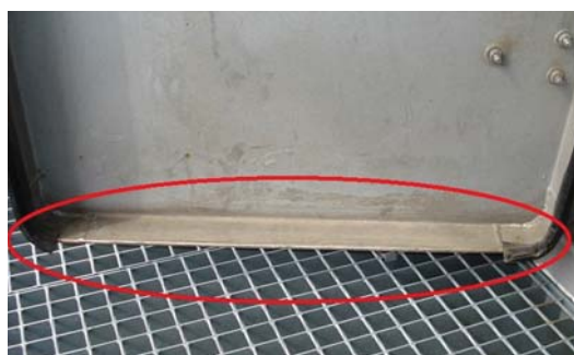
Рис. 2.64. Негерметичность дверей КВОУ: а) уплотнение отсутствует; б) отсутствует часть уплотнения
