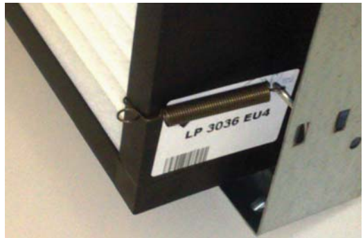
Рис. 3.32. Механизм крепления ФГО в КСФ финской компании AF с помощью пружины
