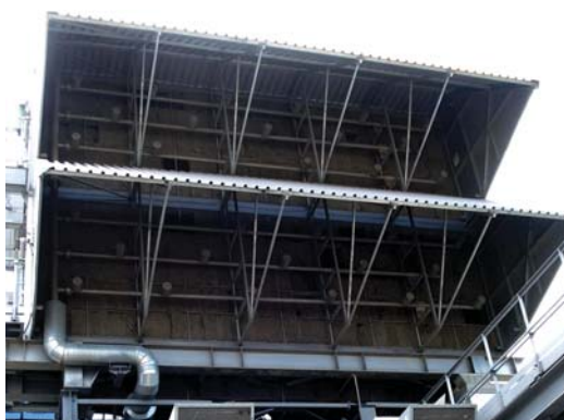
Рис. 2.52. Расположение форсунок распыла противообледенительной системы на КВОУ ГТУ
