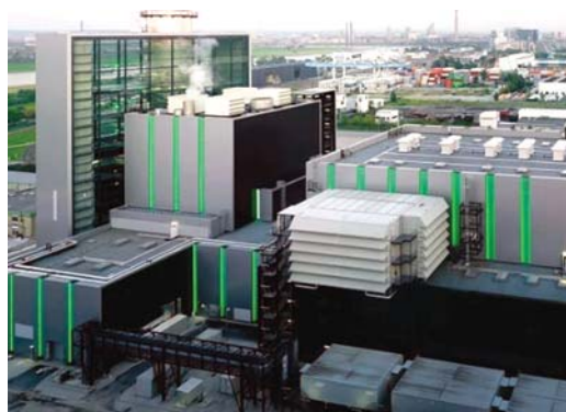
Рис. 4.3. Вид на КБОУ компании FAIST AIS для ГТУ SGT5-8000H энергоблока «Фортуна» электростанции Kraftwerk Lausward в Дюссельдорфе [4]
