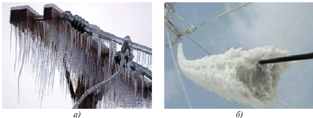
Рис. 2.22. Ледяной дождь: а) на электрических столбах; б) на кабельных трассах ( https://stormandsky.com/09-1-28.html , https://clck.ru/33W23e )
