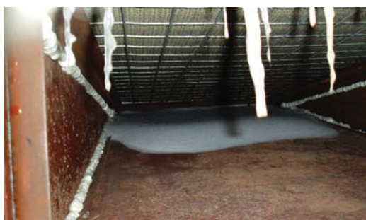
Рис. 2.50. Снег и лед в фильтре первой ступени КВОУ ГТУ ТЭЦ в Тюмени
