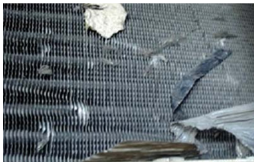
Рис. 2.35. Теплообменный аппарат КВОУ ГТУ с мусором
