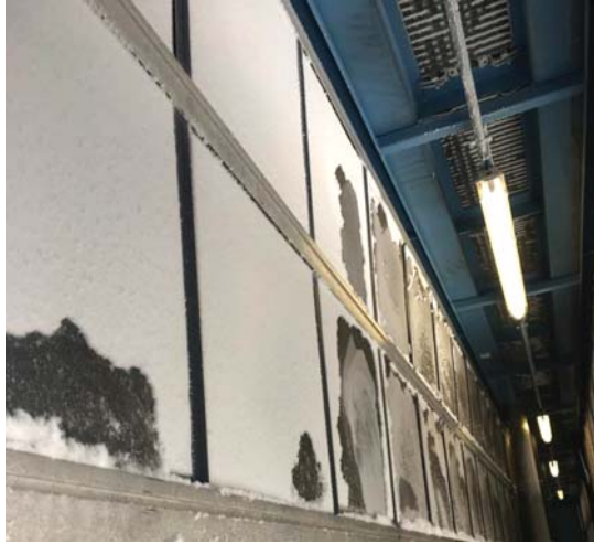
Рис. 2.61. Не снятые на зиму с КВОУ ГТУ противомоскитные сетки
