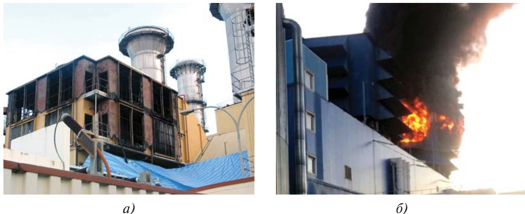
Рис. 3.38. Пожары, вызванные возгоранием фильтров-коагуляторов Poret PPI 10: а) зарубежное КВОУ; б) КВОУ на Ивановских ПГУ
