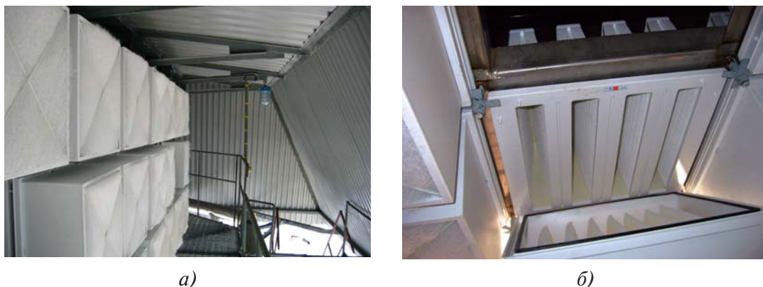
Рис. 3.18. КСФ в ВОУ ГТУ на ГПА: а) в сборе; б) крепление ступеней
