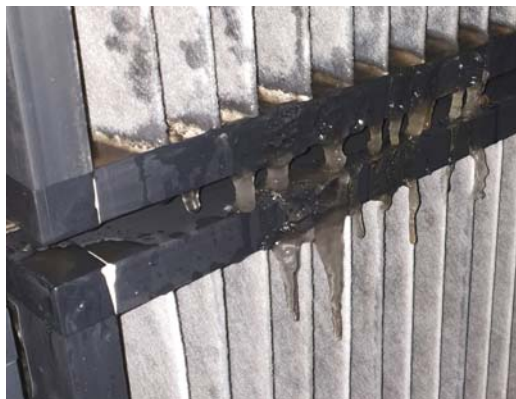
Рис. 2.23. Обледенение панельного фильтра
