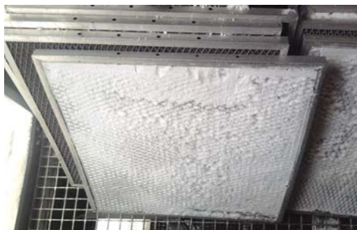
Рис. 2.36. Занос снегом фильтров КВОУ ГТУ
