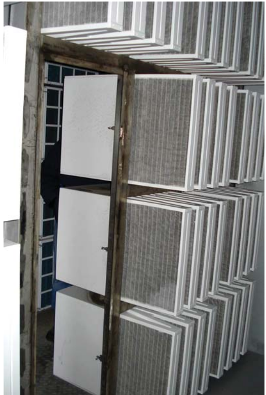
Рис. 3.20. Раздельная установка фильтра-коагулятора и КСФ
