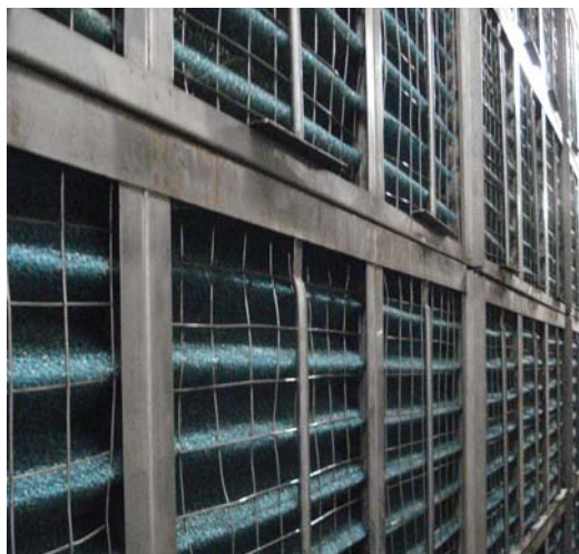
Рис. 2.63. Неправильная установка фильтров в КВОУ ГТУ
