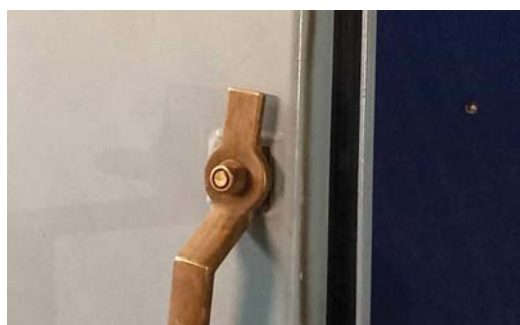
Рис. 2.64. Негерметичность дверей КВОУ: а) уплотнение отсутствует; б) отсутствует часть уплотнения
