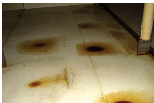
Рис. 2.66. Маслянистые отложения на чистой стороне КВОУ ГТУ
