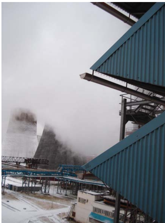
Рис. 2.46. Пар от вентиляторной градирни на всасе КВОУ ГТУ
