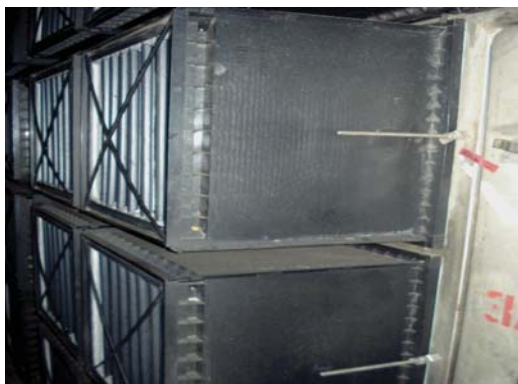
Рис. 3.25. Фильтр-бокс компании Mikropor: а) 3D-макет; б) в КВОУ энергетической ГТУ
