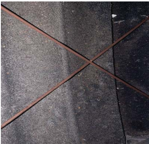
Рис. 2.61. Не снятые на зиму с КВОУ ГТУ противомоскитные сетки
