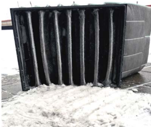
Рис. 3.56. Карманный фильтр зимой: а) блокирование карманного фильтра снегом; б) количество снега, удаленного из фильтра
