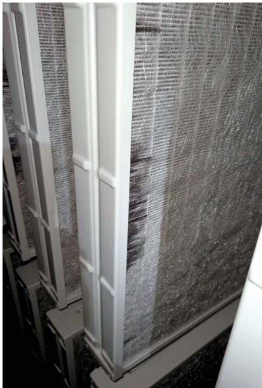
Рис. 3.80. Герметизация стыков фильтровального материала с рамкой кассетного фильтра: а) компании М; б) компании Е.
