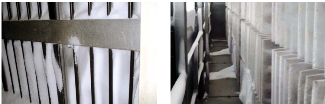
Рис. 3.64. Установка карманных фильтров: а) базовая; б) реверсная
