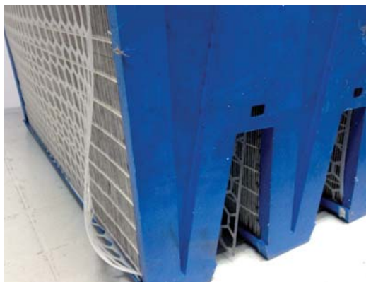
Рис. 3.84. Ненадежно закрепленная защитная синтетическая решетка
