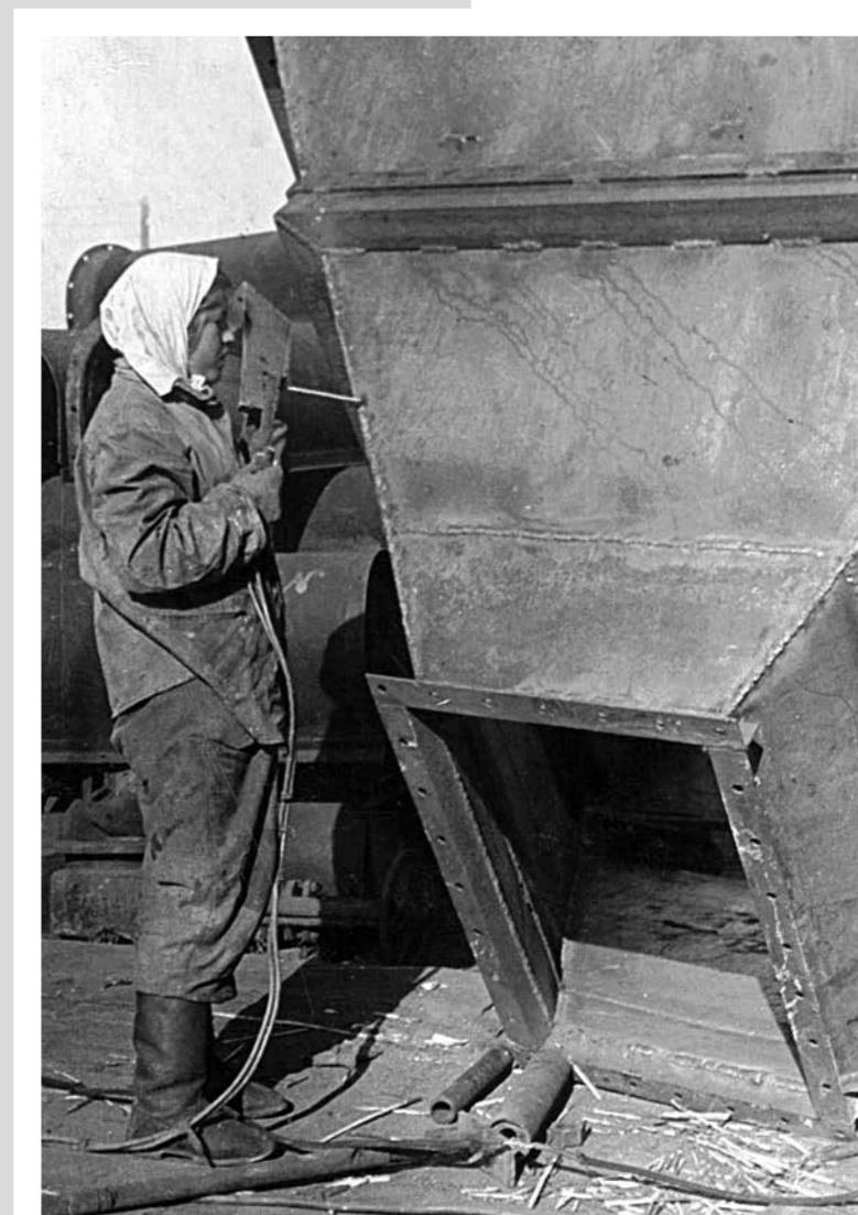
Сварка загрузочного бункера на ТЭЦ-8, 1943 год
