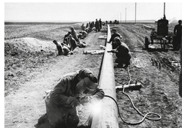
Строительство магистрального газопровода Саратов – Москва
