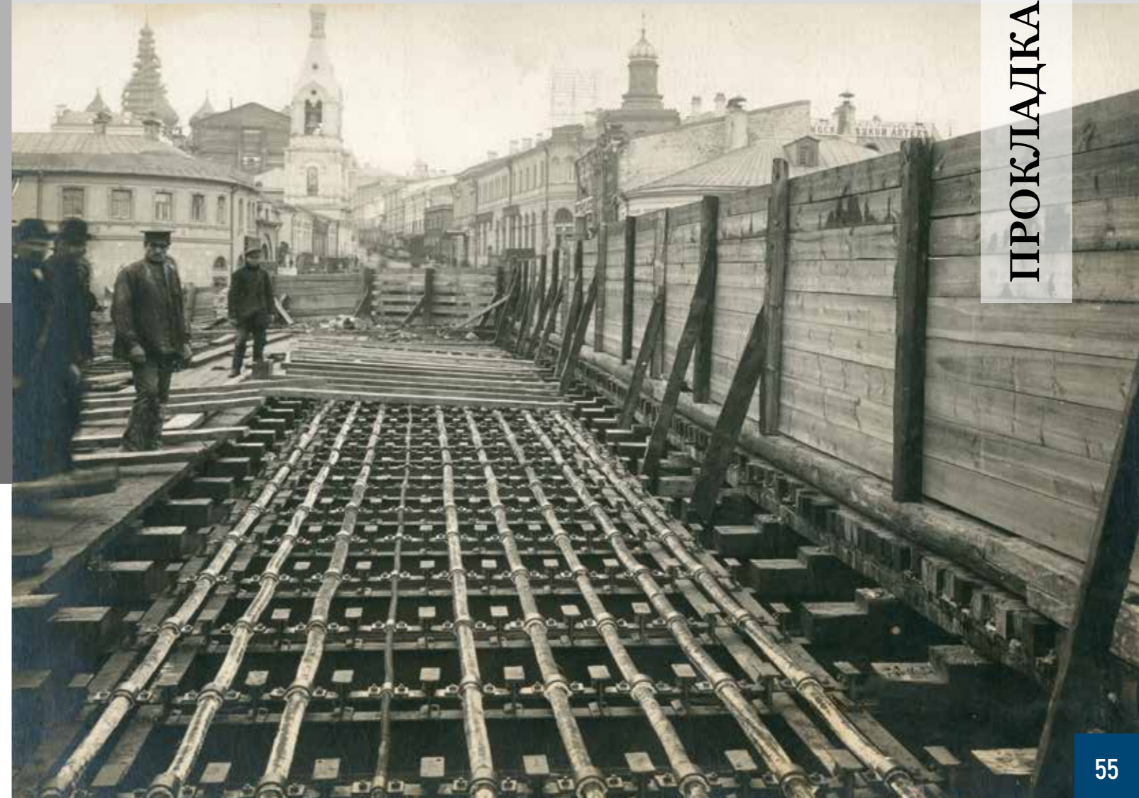
Прокладка кабелей под проезжей частью, начало XX века
